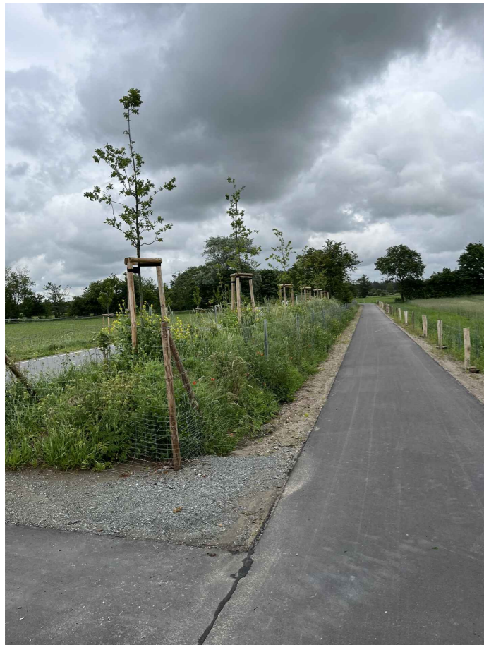
Entlang der Strecke
