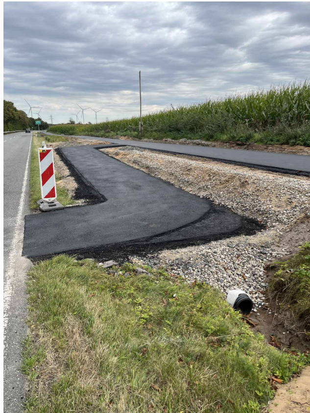
Rampe bei Hausnr. 1
